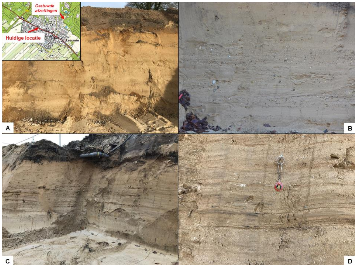
Afbeelding 55: A) noordwand; structuurloos slecht gesorteerd grindhoudend zand en locatiekaart, B) westwand; slecht gesorteerd grindhoudend zand met lokaal geulvorming, C) zuidwand; golvend gelaagd slecht gesorteerd grindhoudend zand, en D) detail van C, sleutelhanger voor schaal (foto's Henk Pagnier & auteur).
