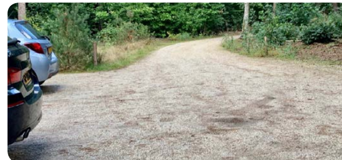
Afb. 4.22 Ondergrond Duurzame waterdoorlatende halfverharding (b.v. Achterhoeks Padvast).
