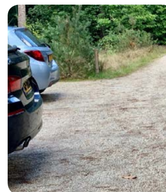
Afb. 4.24 Ondergrond Duurzame waterdoorlatende halfverharding (b.v. Achterhoeks Padvast).
