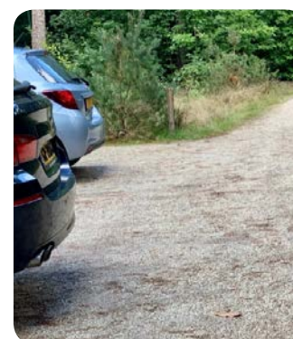
Afb. 4.28 Ondergrond Duurzame waterdoorlatende halfverharding (b.v. Achterhoeks Padvast).
