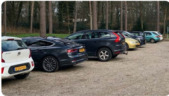
Afb. 4.3 Parkeerplaats aangelegd met duurzame waterdoorlatende halfverharding (bv. Achterhoeks Padvast).
