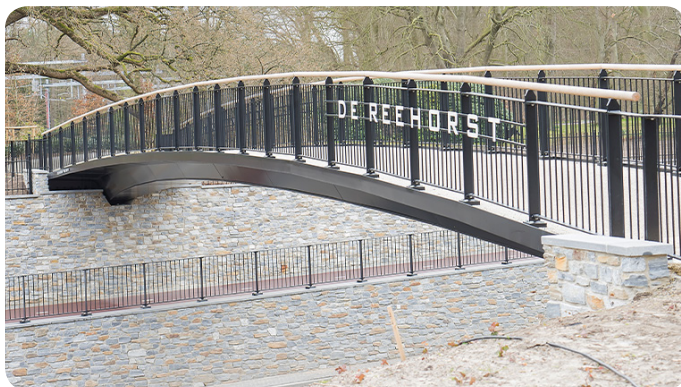
Afb. 4.13 Voetgangers / fietsbrug, station Driebergen-Zeist.
